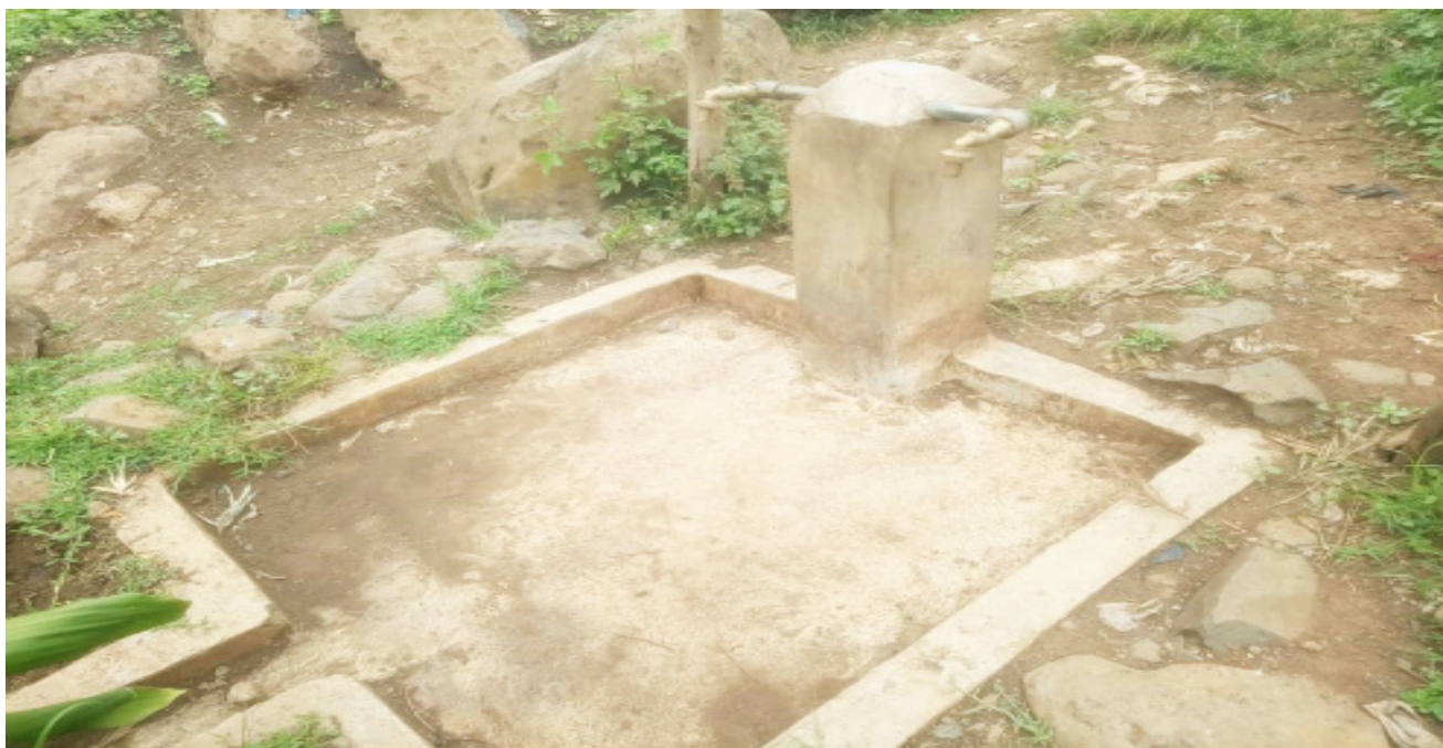
Figure 8 : une borne fontaine construite en faveur de la population à délocaliser, mais où l'eau ne coule plus
