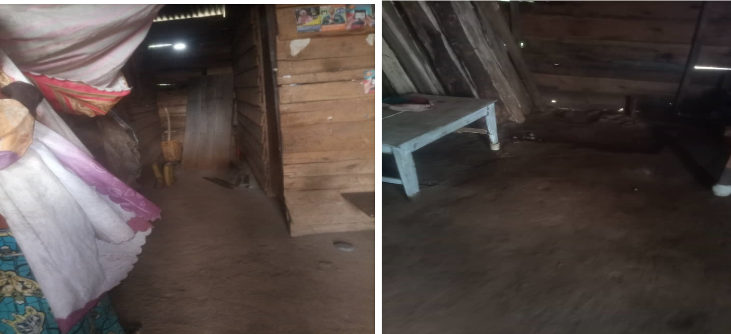
Figure 5 : Site de Cegera, vue de l'intérieur d'une maison
